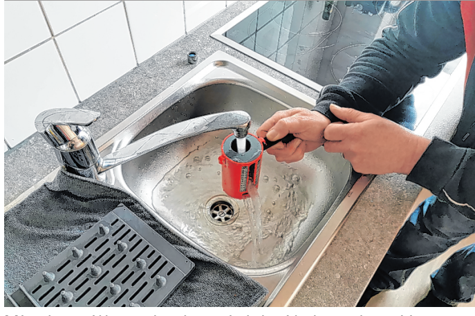
Mit einem Wasserbecher wird der Verbrauch an Litern pro Minute gemessen.
