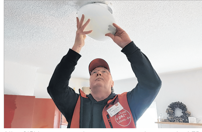
Alle Glühlampen werden gegen energiesparende LED-Leuchten ausgetauscht.
